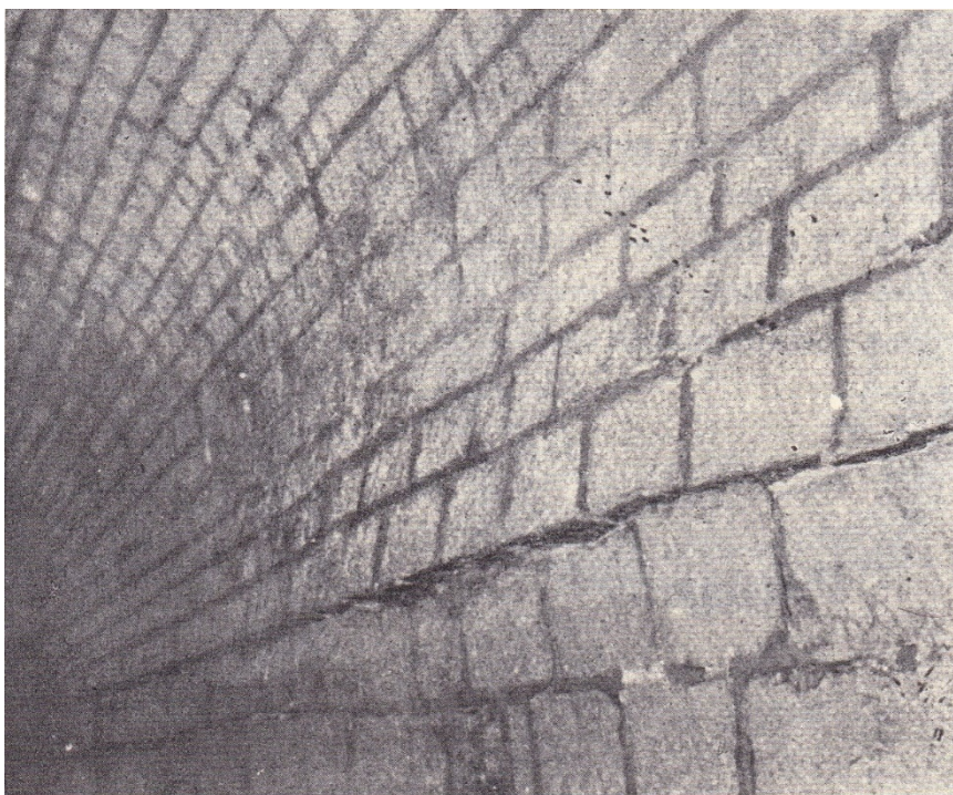
Fig. 18 - Rigonfiamenti e segni di cedimento di una parete dell'emissario. Stessa fonte dell'immagine precedente.
